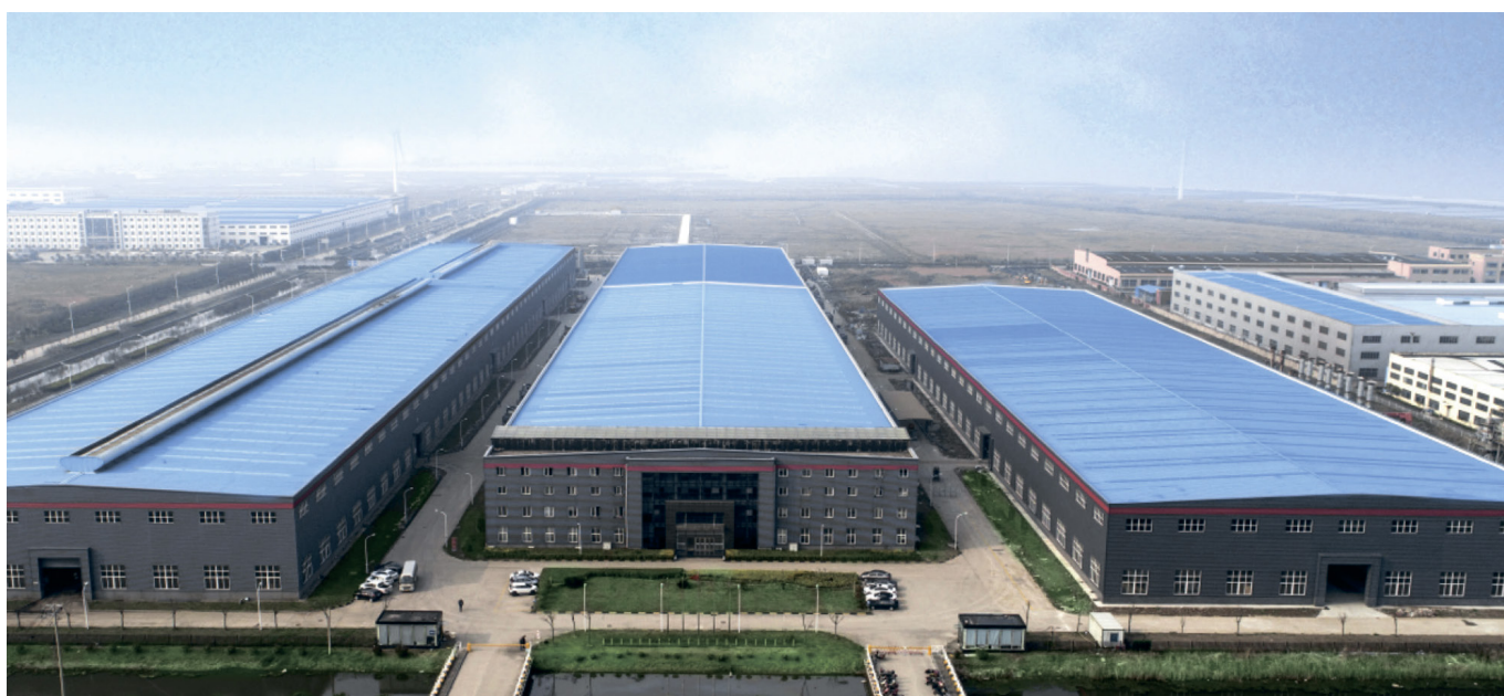
Цзяоцзуо Цех высокоточного литья
